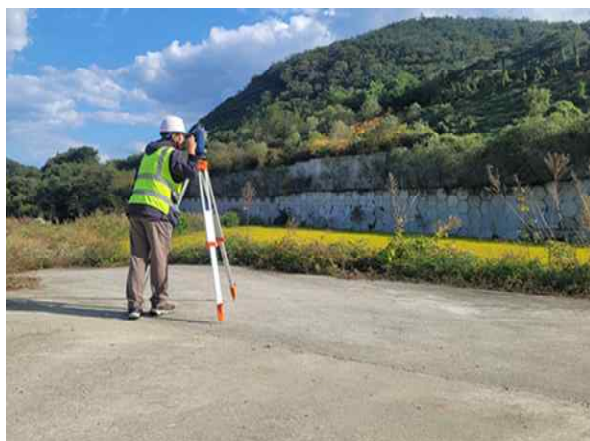
광파기를 이용한 측량 작업
