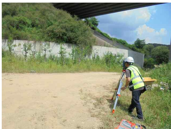
광파기를 이용한 측량 작업
