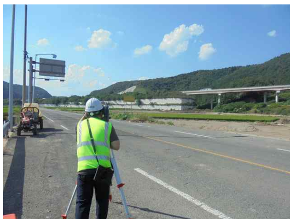
광파기를 이용한 측량 작업
