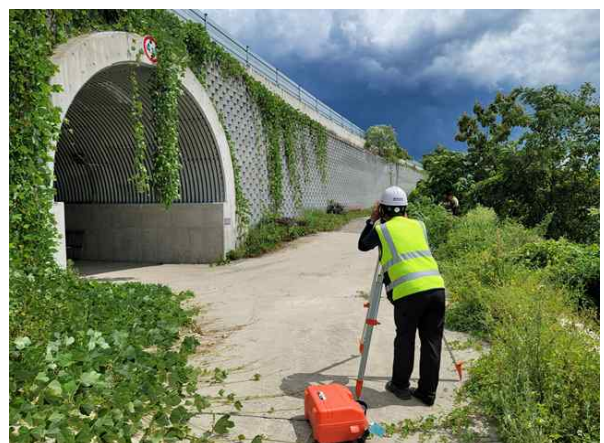
광파기를 이용한 경사도 측정
