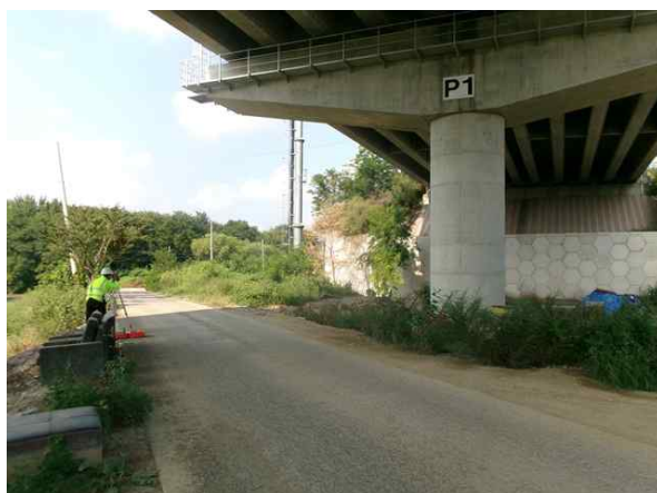
광파기를 이용한 측량 작업
