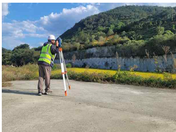
광파기를 이용한 측량 작업
