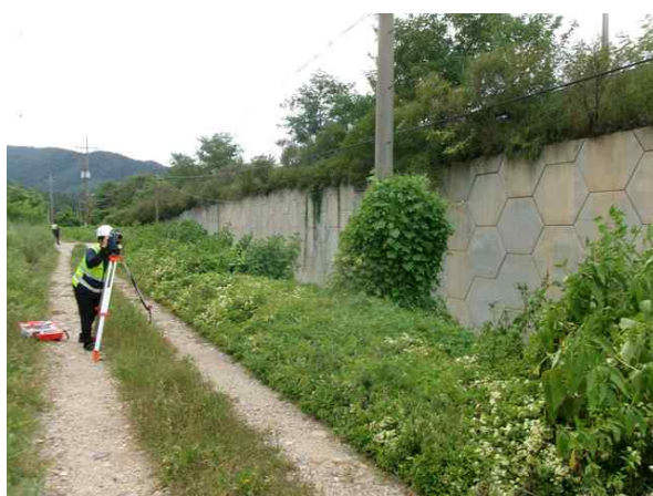
광파기를 이용한 측량 작업
