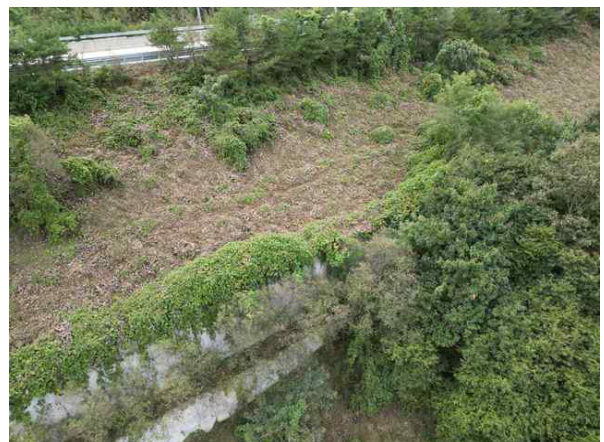
상부 성토부 전경
