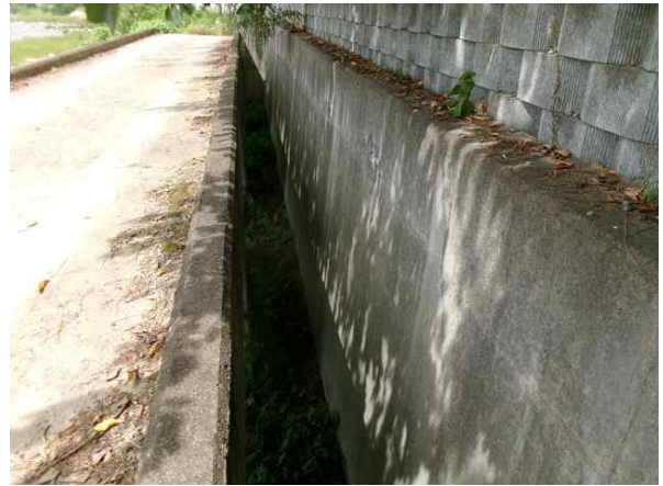
하부 배수로 전경
