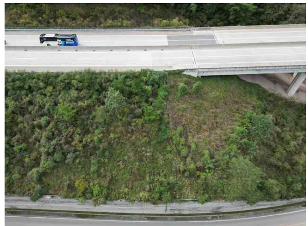
상부 성토부 전경
