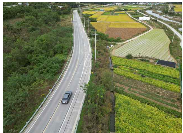
상부 성토부 전경
