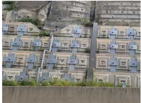
배수관, 배수로 전경
