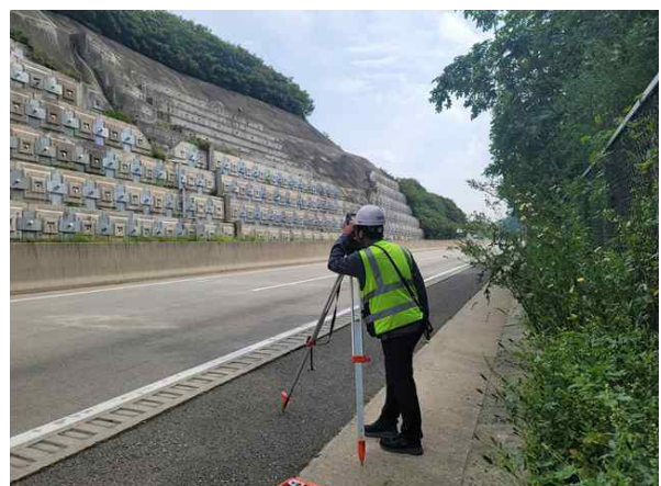
광파기를 이용한 경사도 측정
